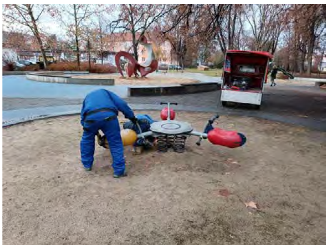
Výměna prasklé pružiny na dětském hřišti u kohouta
