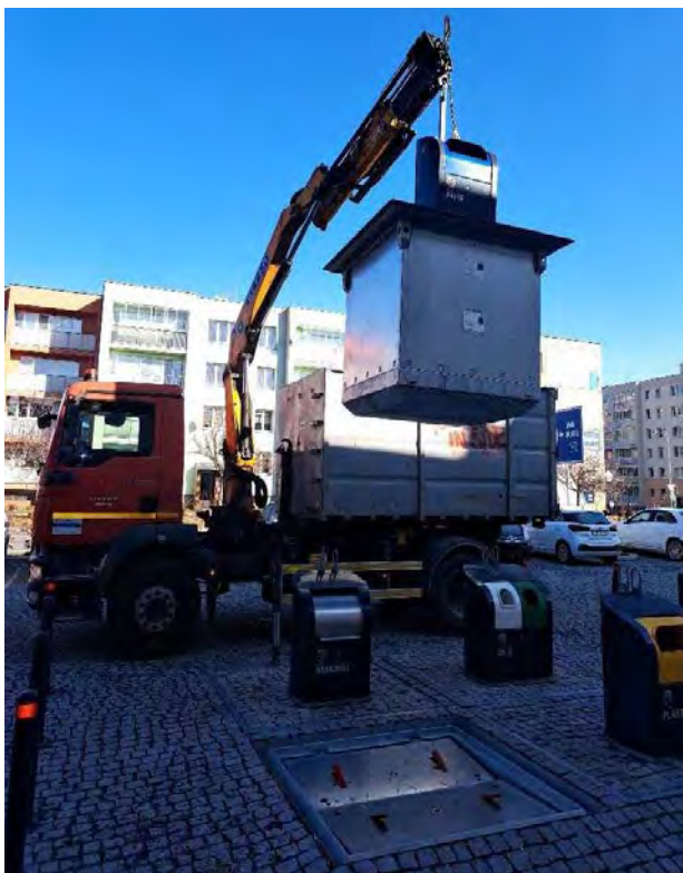
Vývoz podzemních kontejnerů svoz odpadu
