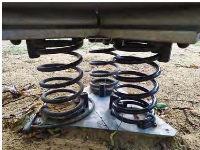
Výměna prasklé pružiny na dětském hřišti u kohouta
