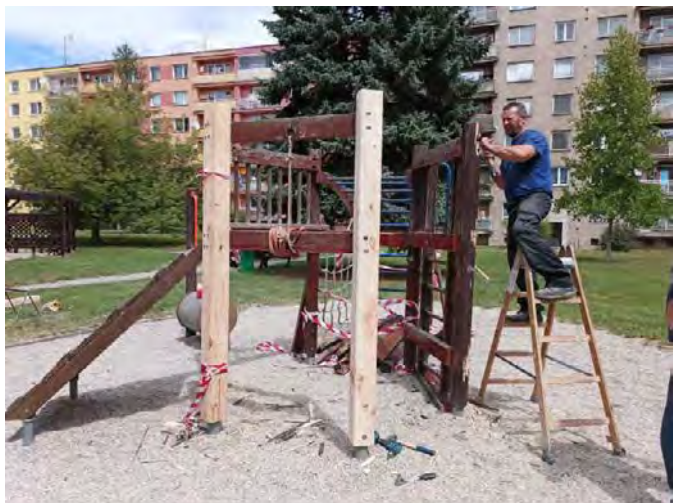
Výměna poškozeného sedáku na dětském hřišti ul. Tyršova
